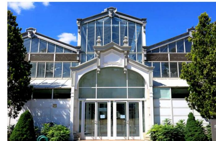
La construcción es en esencia una gran estructura metálica, cubierta con un sistema de naves a dos aguas adosadas, resaltando del conjunto en altura las naves correspondientes a los dos ejes principales que se cortan en forma de crucero.
