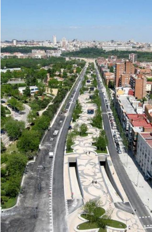
El soterramiento de la avenida de Portugal en el tramo comprendido entre el Alto Extremadura y la M-30 ha permitido cambiar una carretera por un bulevar ajardinado de 19,50 metros de anchura y 1.480 metros de longitud, a través del cual se puede acceder directamente al río y a la Casa de Campo.
